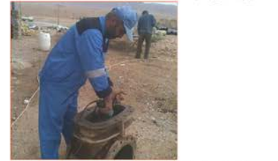
تعمیر و تعویض شیرآلات خراب در امور آب و فاضلاب گرمه
